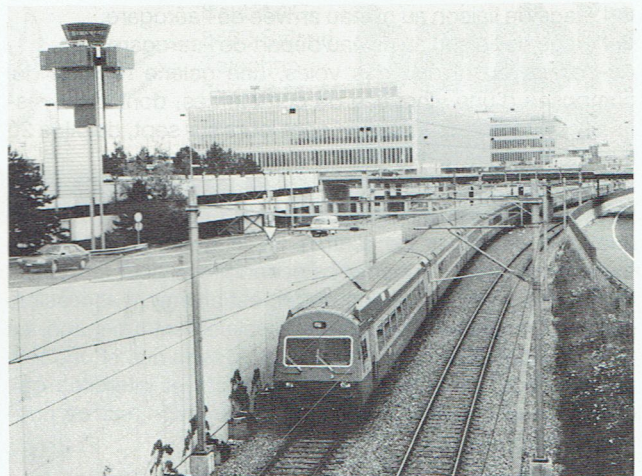
2: La nouvelle double voie Genève-Aéroport (source: P.-A. Vaucher).
