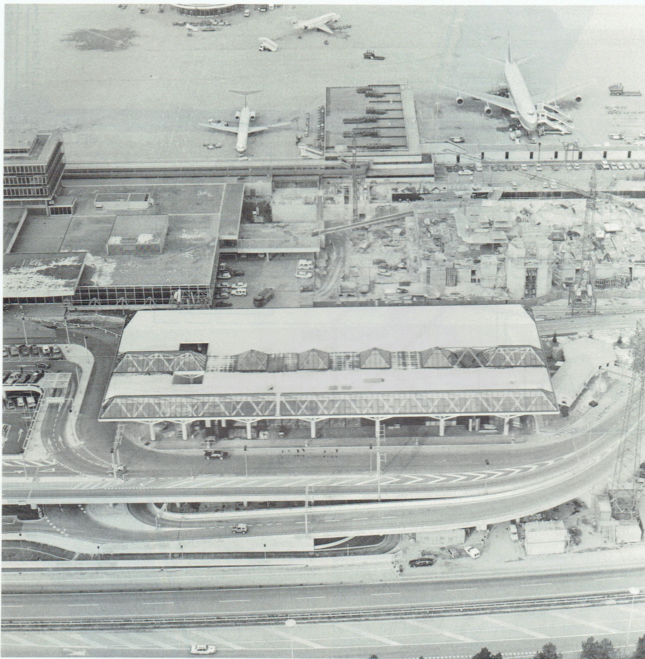
3: Gare de Genève-Aéroport (source: Brutsch & Brutsch, Genève).
