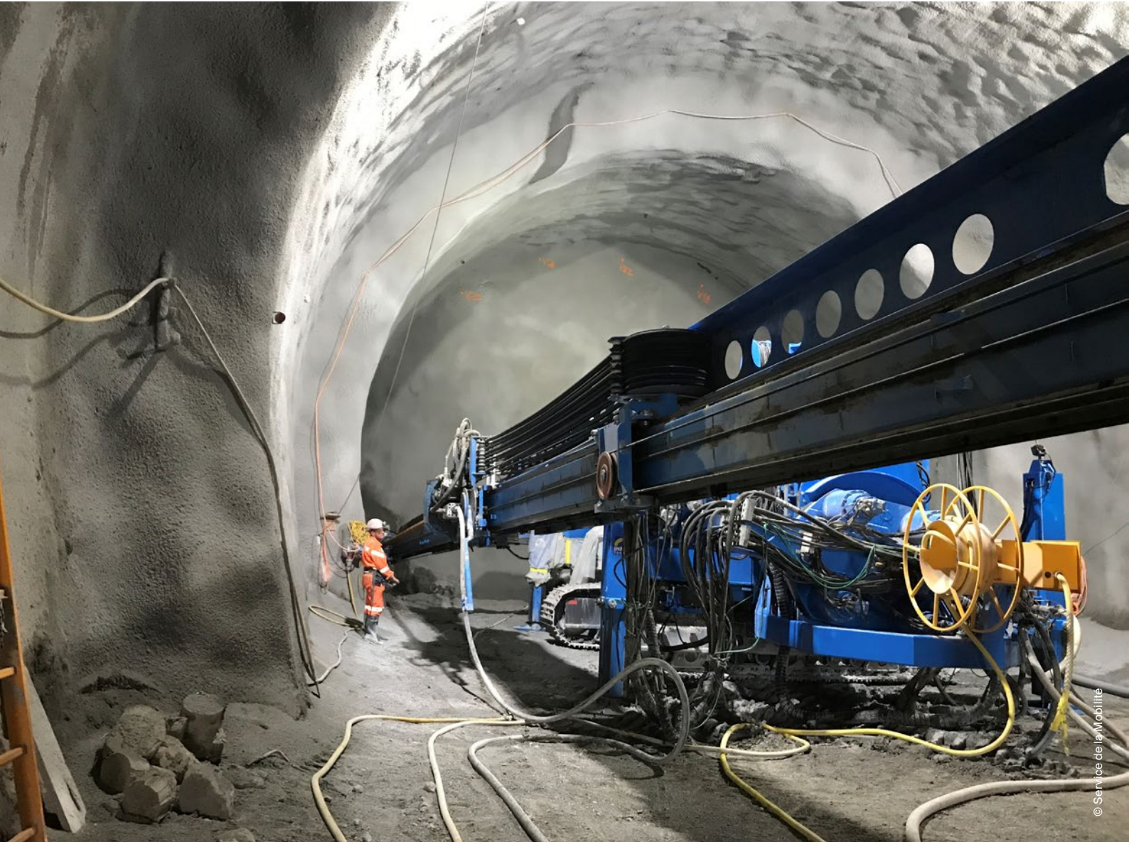
Chantier du Tunnel des Évouettes (Valais).
